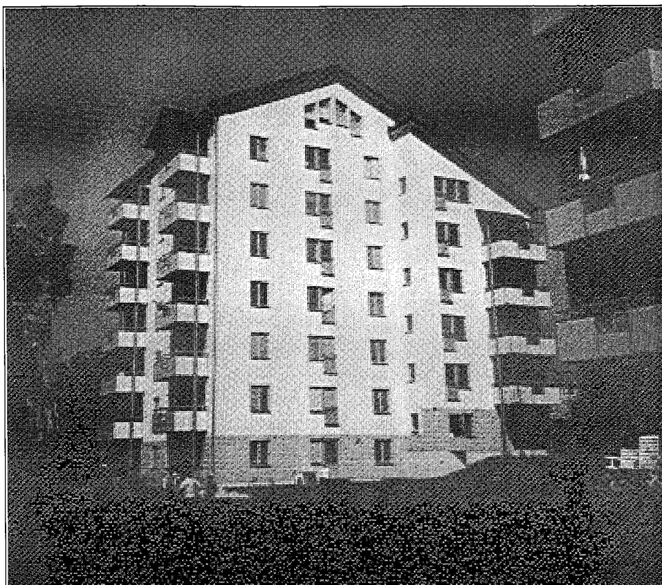
Sjuvånings punkthus i kvarteret Kaskaden, Hässelby. De två husen är de hittills högsta husen i Sverige som byggts med lättbyggnadsteknik.
